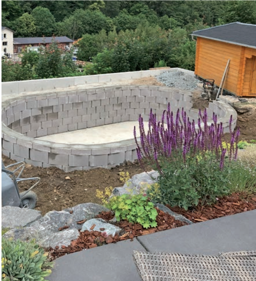
Schwimmbadbau im Rohbau
