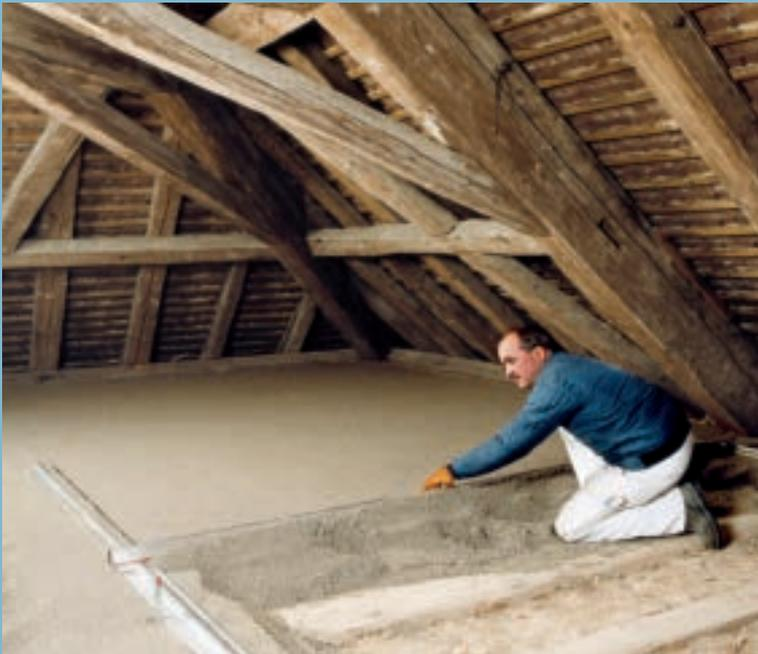
Alte Rohböden sind auf Tragfähigkeit zu prüfen, Unebenheiten bekommen Sie durch die gebundene Schüttungen Knauf EPO-Leicht in den Griff.
