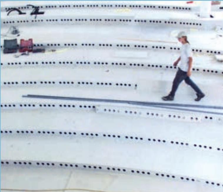
Einbau eines GIFAfloor LBS Systems in einen Konzertsaal mit Zuluffführung.
