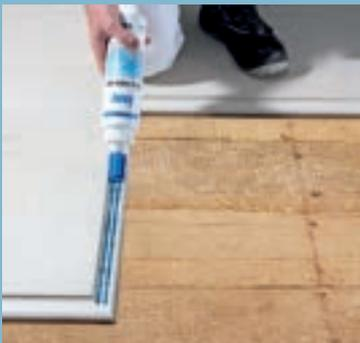
Knauf Brio Falzkleber wird auf den unten liegenden Stufenfalz aufgetragen.
