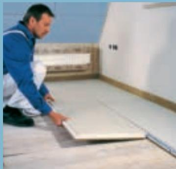
Das nächste Brio-Element wird in den Kleber eingelegt und verschraubt oder verklammert, fertig.
