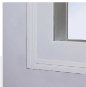
Kunststoff-Abdeckleiste, stumpf gestoßen
